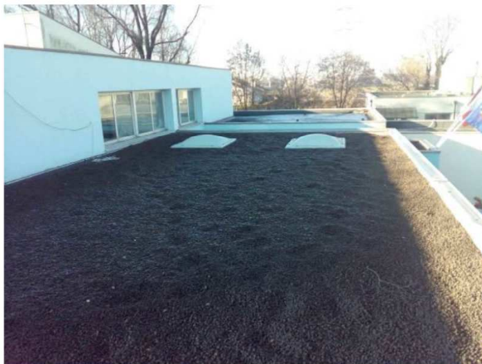
Figura 12 - copertura lato nord
