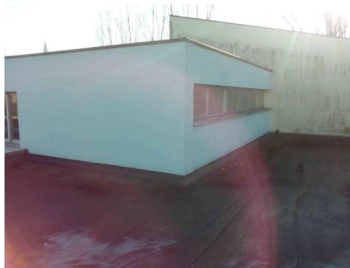
Figura 11 - copertura angolo nord-ovest
